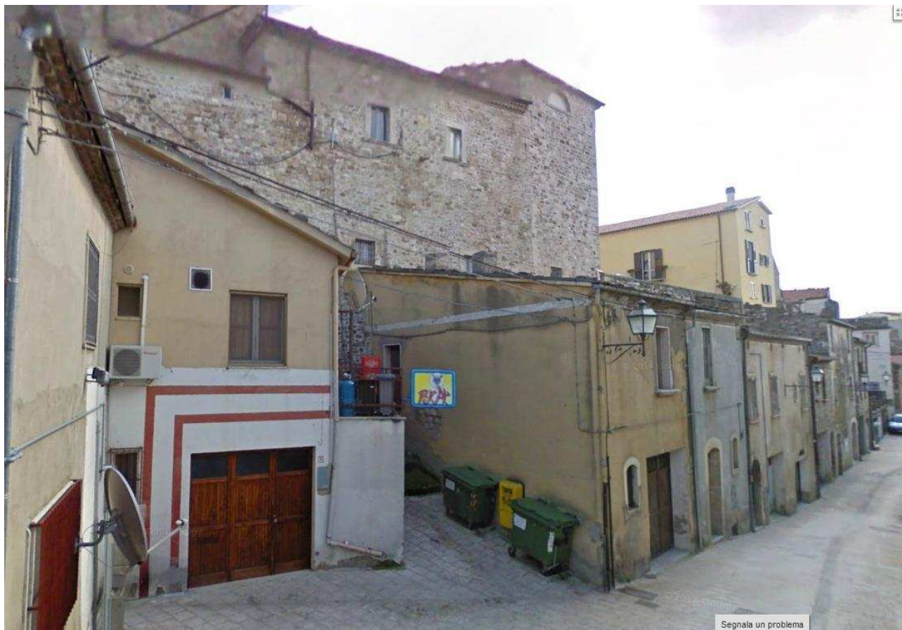
Chiesa Parrocchiale, Lato occidentale: edifici Otto/Novecenteschi addossati alla chiesa e alle mura perimetrali dell'abitato (Google Maps)
