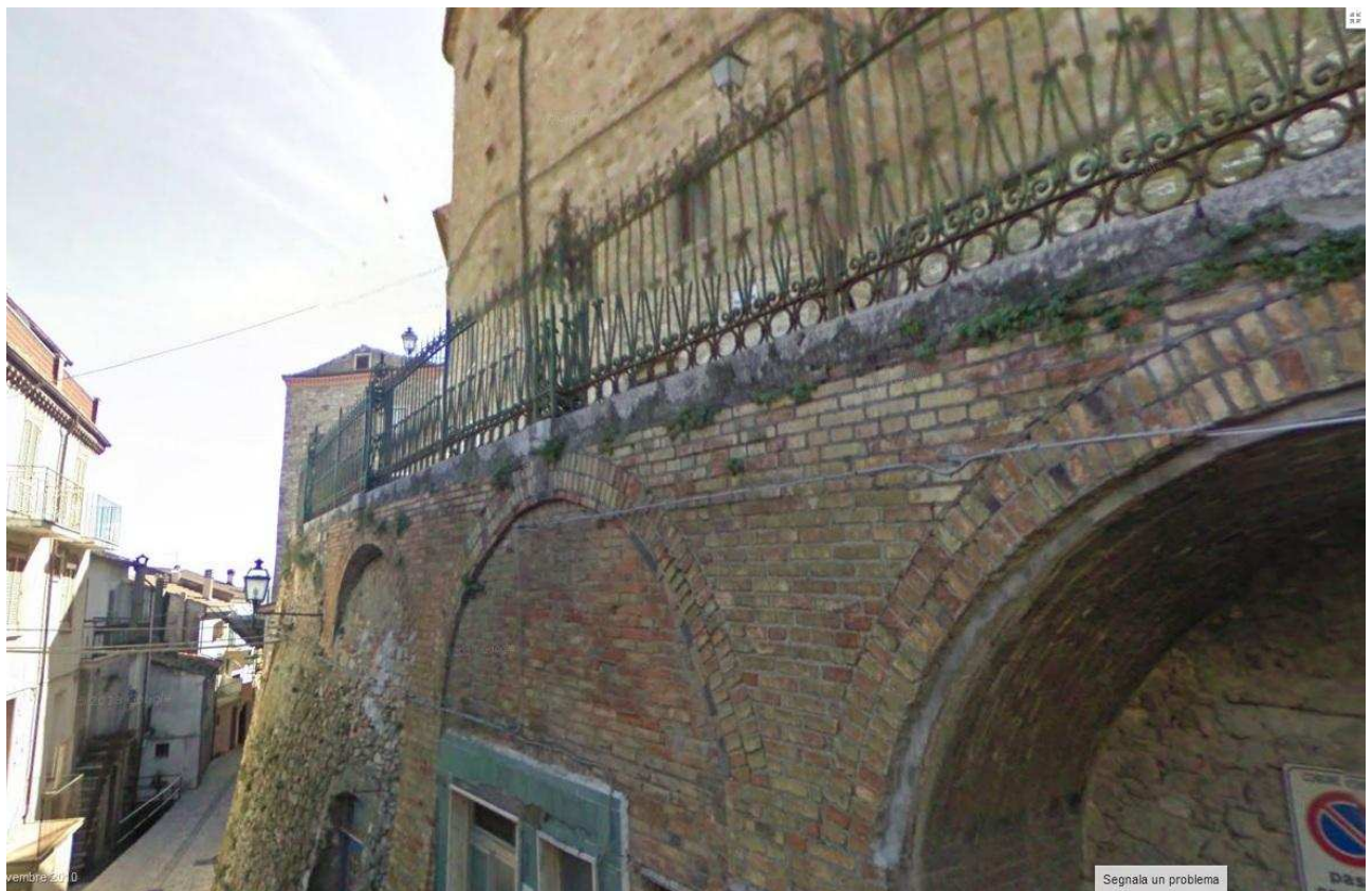
Aspetti dei contrafforti di Via Sotto il Barbacane, lato orientale (Google Maps)
